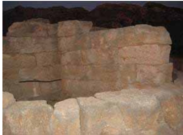
Grundmauer des Hafenturmes
